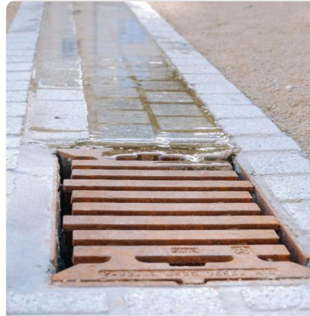
Direktes Einleiten von Regenwasser in die Wurzelbereiche
