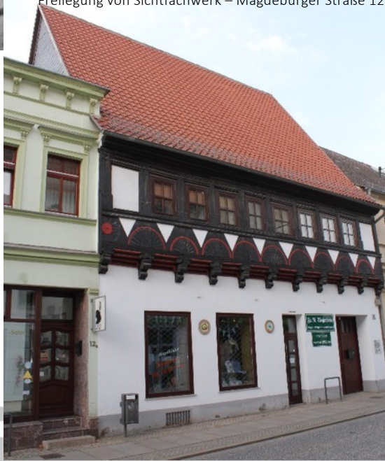
Freilegung von Sichtfachwerk – Magdeburger Straße 12
