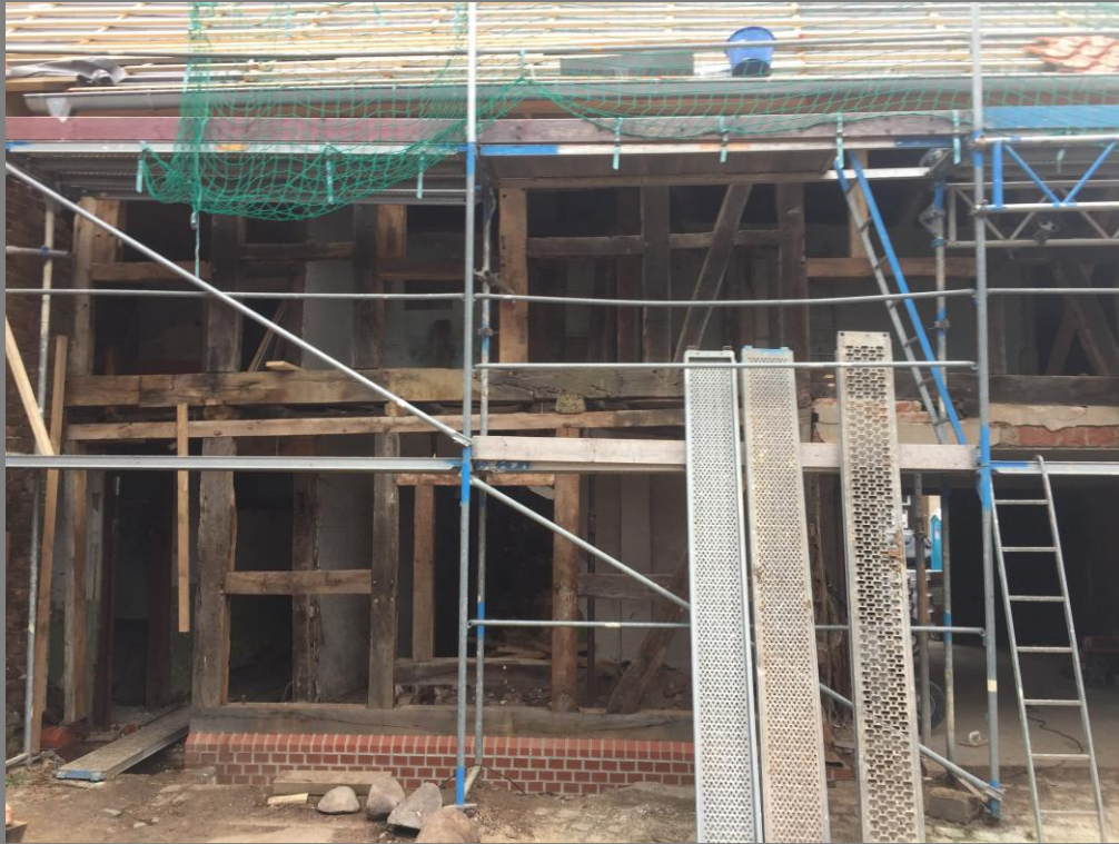
Foto :Sicherungsmaßnahme / Gerüst / Sanierung
