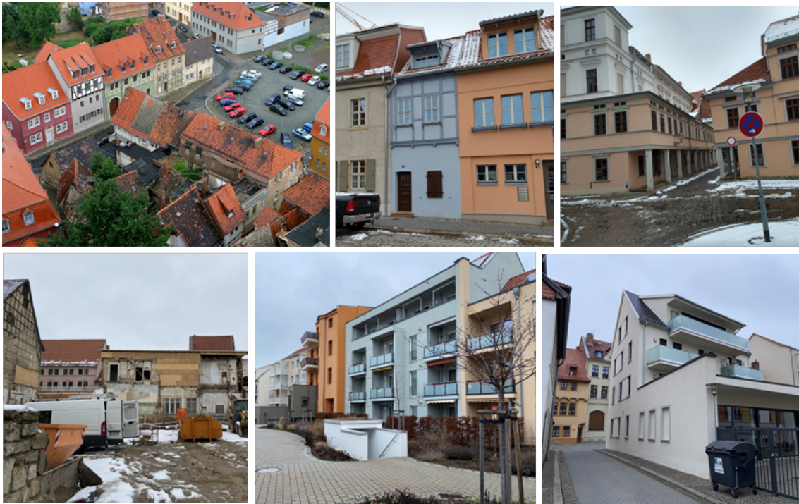
Abbildung 6.9: Sanierung in der Innenstadt von Aschersleben
