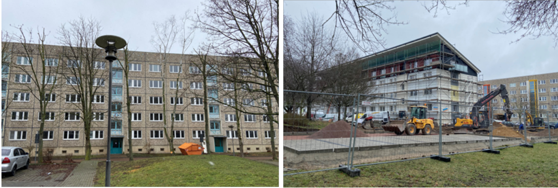
Abbildung 6.7: Teilrückbau und Modernisierung in der Kopernikusstraße
