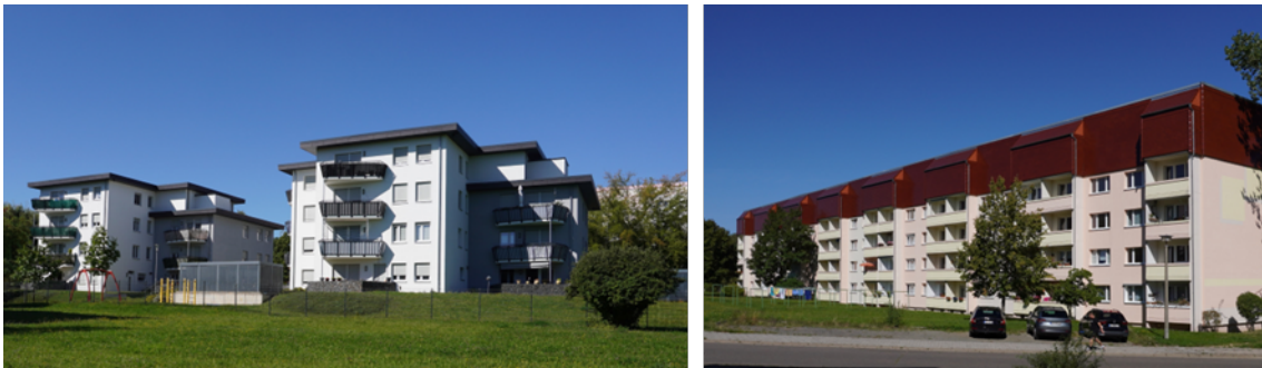
Abbildung 6.19: Neubau und Wohngebäude mit stillgelegtem oberem Geschoss im WG III
