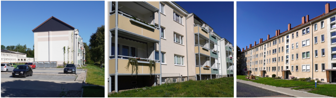
Abbildung 6.18: Teilrückbau sowie für den Rückbau vorgesehenes Gebäude im WG II
