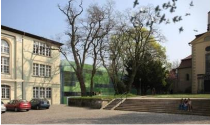
Altbau und Neubau Campus Technicus Schulstandort II für 9. und 10. Klassen
